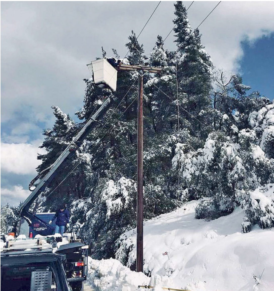
Αποκατάσταση βλαβών στο δίκτυο της ΔΕΗ στο Πήλιο.
